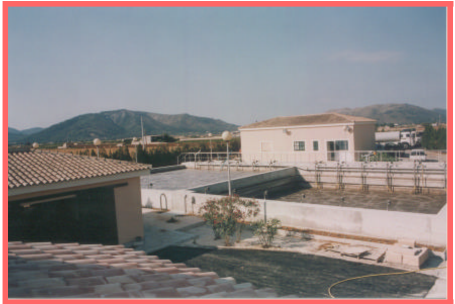
Vista general de la planta. Sa Pobla (Mallorca)
