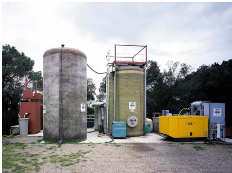
Detalle del SBR y del depósito adicional de almacén (opcional)
