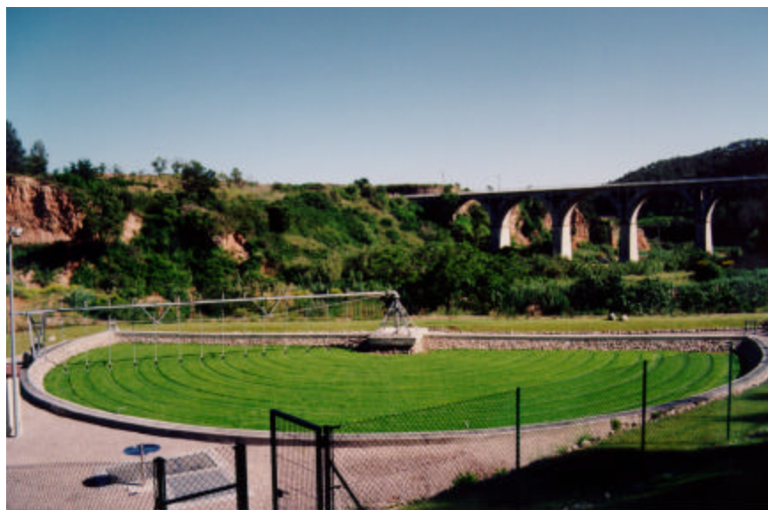
Vista general del tratamiento terciario por infiltración - percolación de Piera (Barcelona)
