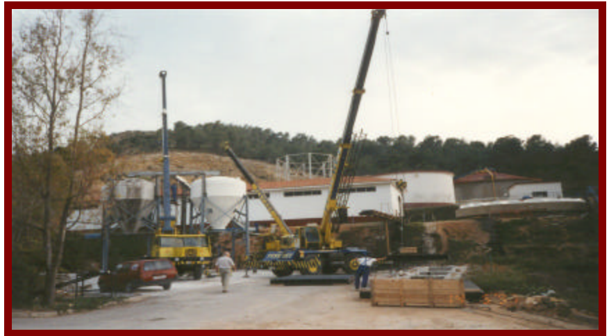
Vista general de las obras. Benidorm (Alicante)
